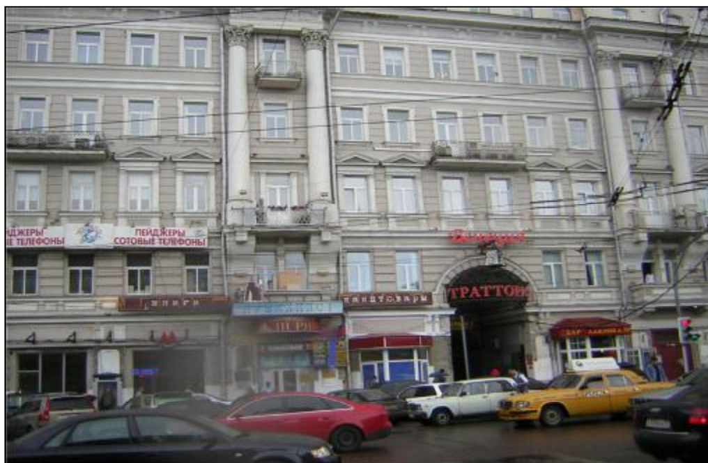
Фото. 1. Внешний вид здания, в котором расположен объект оценки
